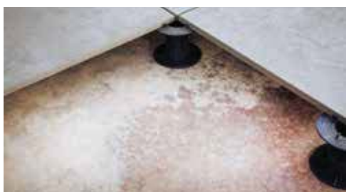
POKLÁDKA NIVELIZAČNÝM SYSTÉMOM
