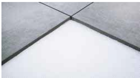
POKLÁDKA DO CEMENTOVÉHO LÔŽKA
