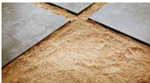
POKLÁDKA DO PIESKOVÉHO LÔŽKA
